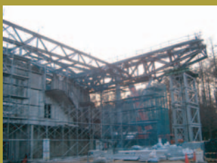
鉄骨建方の様子
