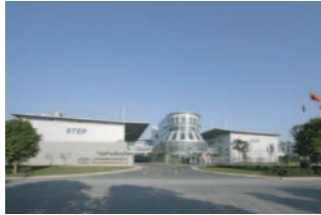
上海STEP(08年10月竣工)
